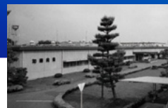
新設当時の真岡工場
