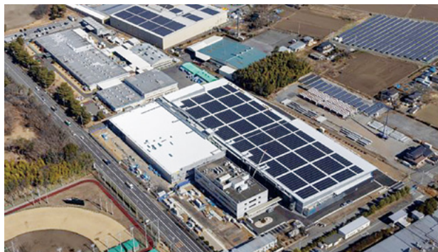
新真岡工場 太陽光パネル
