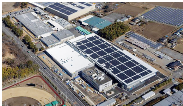
新真岡工場 太陽光パネル
